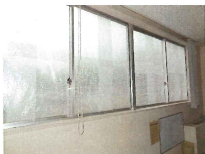
山形工場1F窓、断熱シート設置
